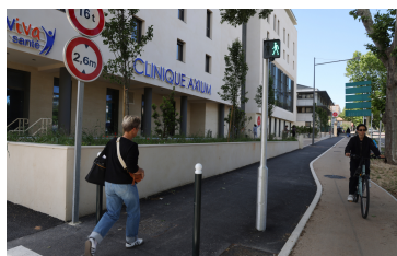
Le nouveau bâtiment de la clinique Axiom, construit sur l'ancien parking en surface.
